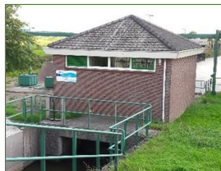
Foto 9 Gemaal Putten Nuldernauw
