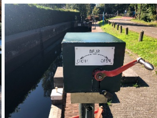
De Weersluis en Kraaienestersluis worden met de hand bediend door schippers zelf. Mensen moeten daarvoor de boot verlaten.
