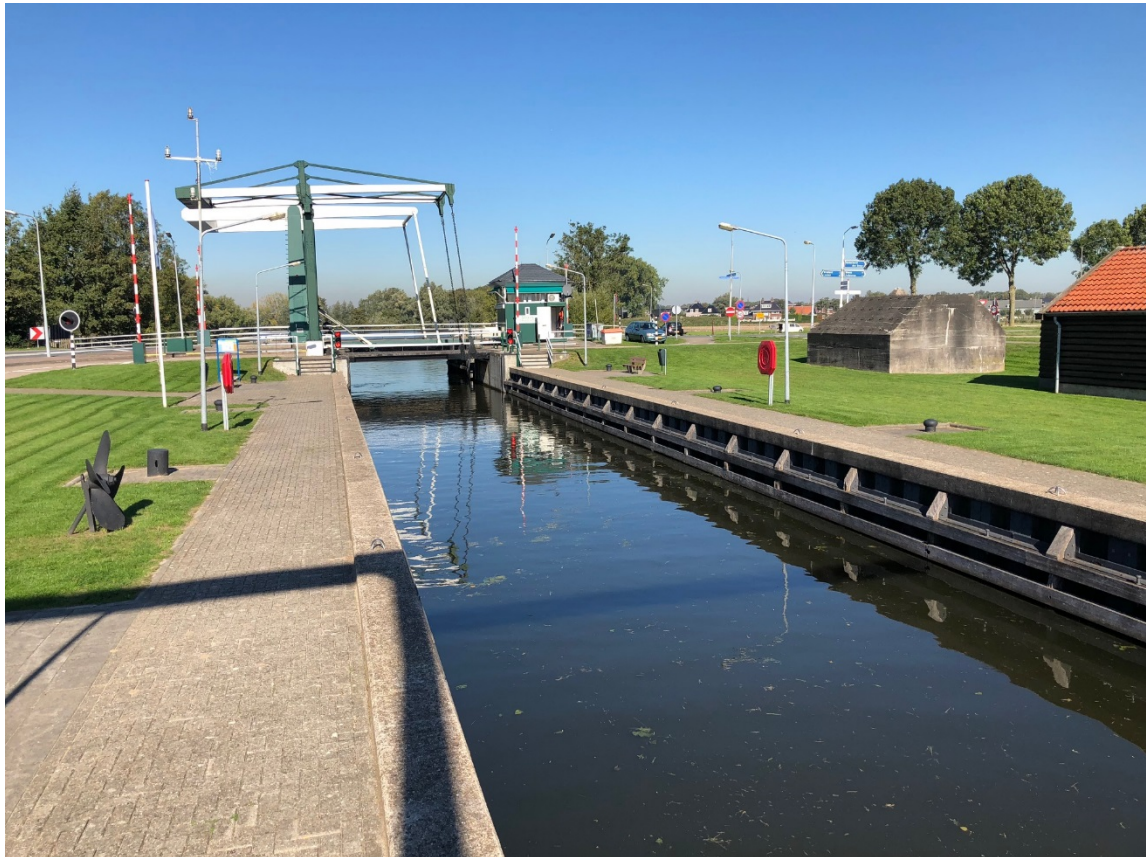
Sluis 't Hemeltje is een ruime sluis die vanuit een bedieningspost wordt bediend
