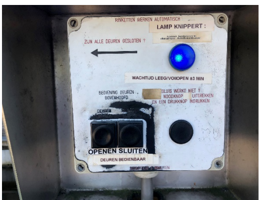
Drukke in de Mijndensesluis, mechaniek voor bediening Kraaienestersluis en Raaisluis met uitleg
