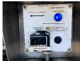
De Raaisluis is een geautomatiseerde zelfbedieningsluis die met een paneel met knoppen en uitleg wordt bediend. Mensen moeten daarvoor de boot verlaten
