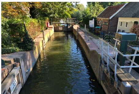
De Weersluis en Kraaienestersluis worden met de hand bediend door schippers zelf. Mensen moeten daarvoor de boot verlaten.
