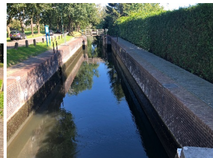
De Weersluis en Kraaienestersluis worden met de hand bediend door schippers zelf. Mensen moeten daarvoor de boot verlaten.
